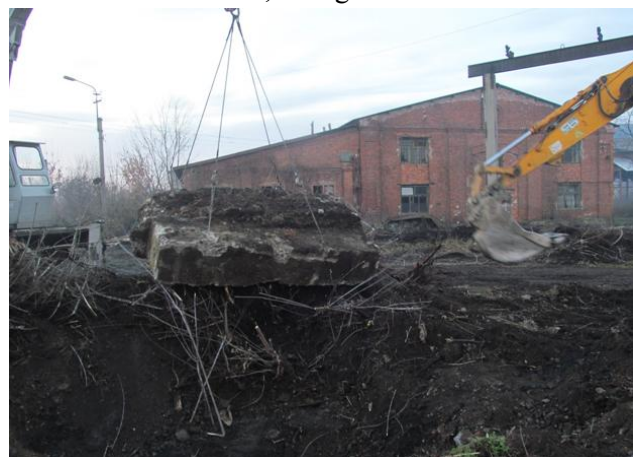
Betontömbök, törmelék eltávolítása
