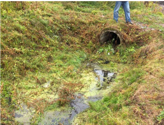
A vízvezető csatorna a gyár területén felújítás előtt
