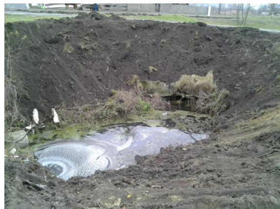
Csatorna rekonstrukció földmunkák a gyár területén kívül
