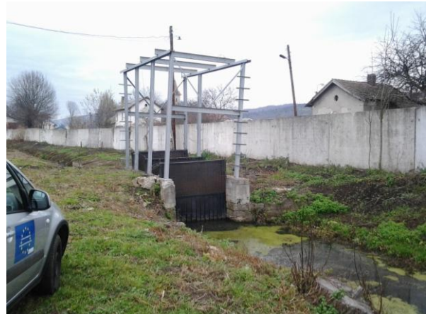
Felújított víztisztító műtárgy
