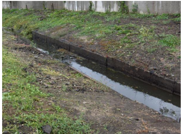
A vízvezető csatorna a gyár területén felújítás után
